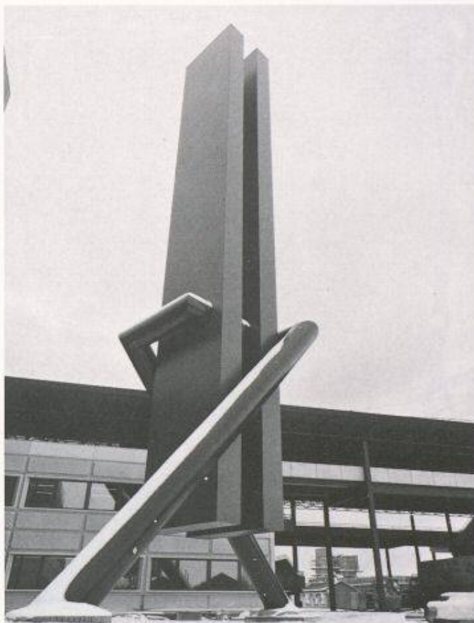
«Jockey 27», von André Nallet, Carouge 1980. Eingang ETH Lausanne, Bauingenieur-Abteilung. Ingenieur: Clément+Bongard, Fribourg; Ausführung: Geilinger AG, Yvonand. Die beiden nur im unteren Teil miteinander verbundenen Hohlkörper sind schräg auf gewinkelten Stahlrohren abgestützt. So erscheint die 27 m hohe Plastik schwebend. Verkleidung mit farbigen Aluminium-Panelen.
