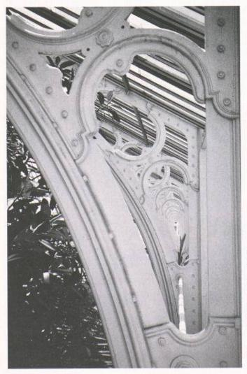
Palmenhaus Kew Gardens, London 1844 bis 1848. Gussteile werden nicht nur als Verzierung, sondern auch – mit bemerkenswertem statischen Gefühl – als hochbeanspruchte Konstruktionsteile eingesetzt.
