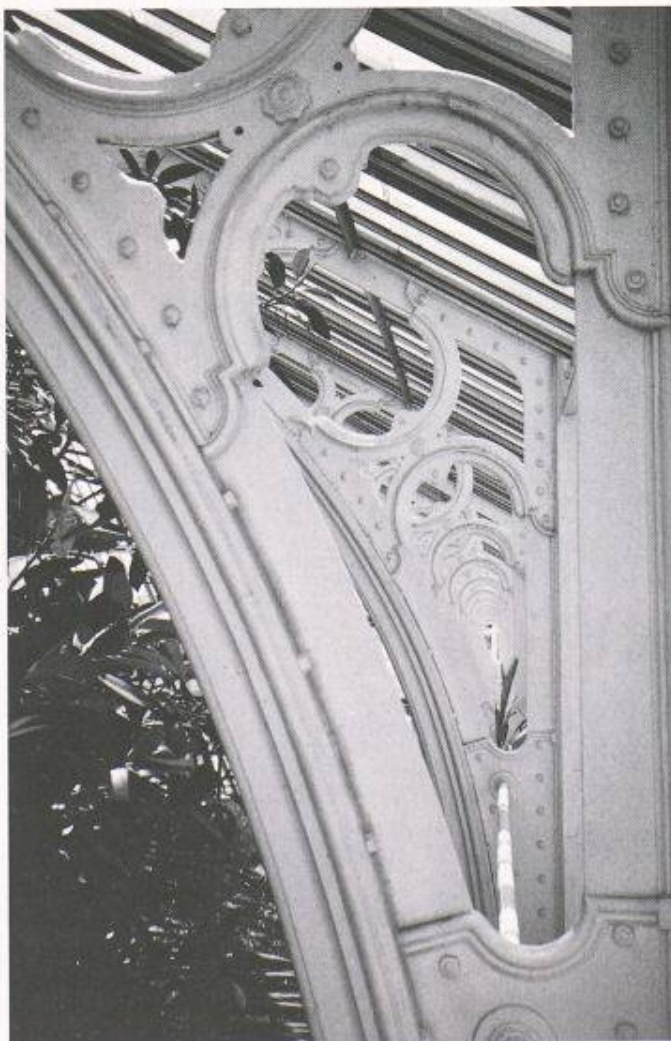
Palmenhaus Kew Gardens, London 1844 bis 1848. Gussteile werden nicht nur als Verzierung, sondern auch – mit bemerkenswertem statischen Gefühl – als hochbeanspruchte Konstruktionsteile eingesetzt.
