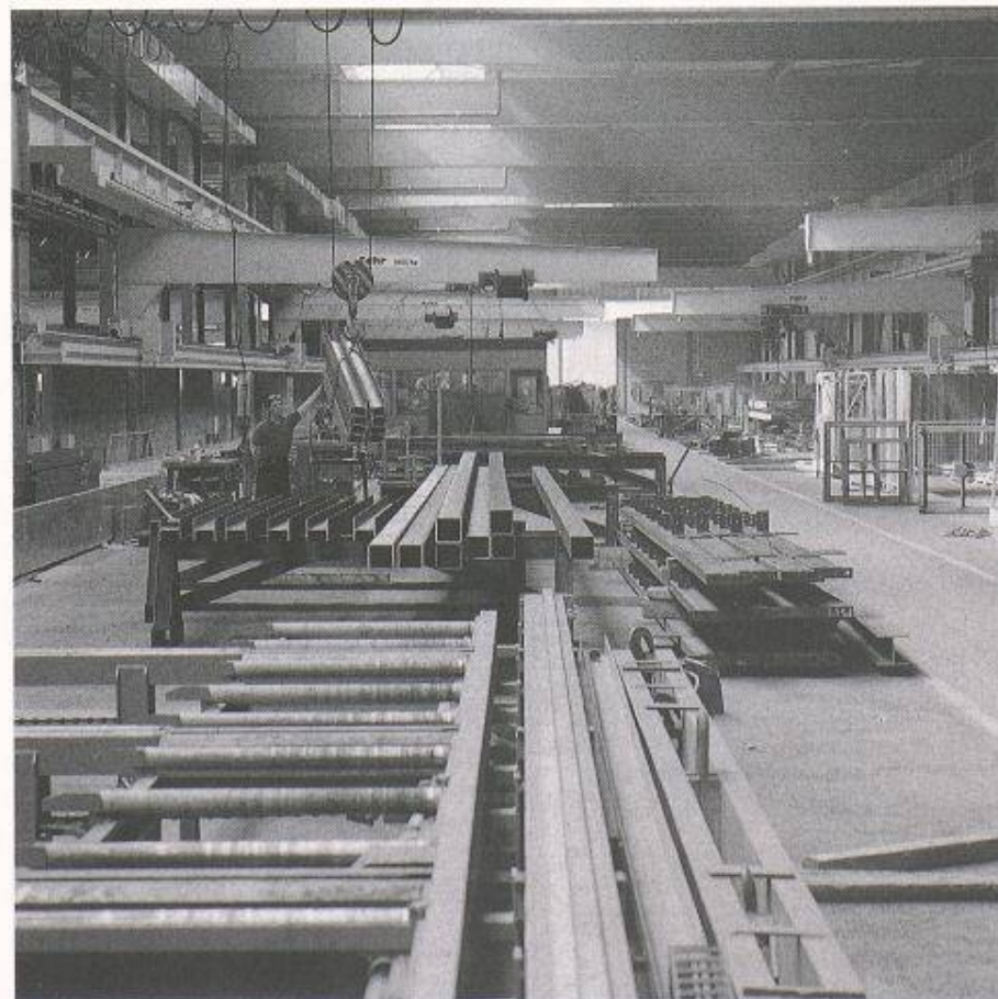
Bild 4. Fertig installierte Hallen mit Lauf- und Konsolkränen
