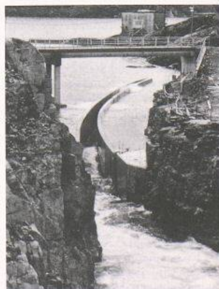
Bild 4. Tapchan von Norwave auf Toftefjallen, Norwegen. Maximale elektrische Leistung 350 kW. Blick von der Fassung zum «Tapered Channel» (Spitzkanal) und zum Ausgleichsbecken
