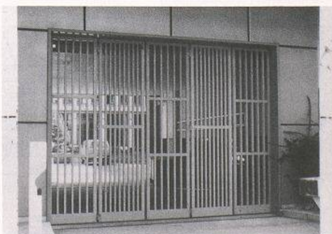
Gitter-Falttorfront als Abschluss für Sicherheitsschleuse für Geldumschlag: Robuste Bauweise, rasches Öffnen, lange Lebensdauer
