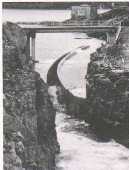
Bild 4. Tapchan von Norwegen auf Toftestallen, Norwegen. Maximale elektrische Leistung 350 kW. Blick von der Fassung zum «Tapered Channel» (Spitzkanal) und zum Ausgleichsbecken
