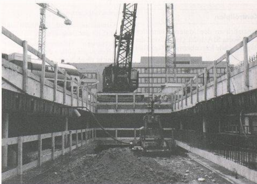
Bild 3. Aushub bei Deckelbauweise
