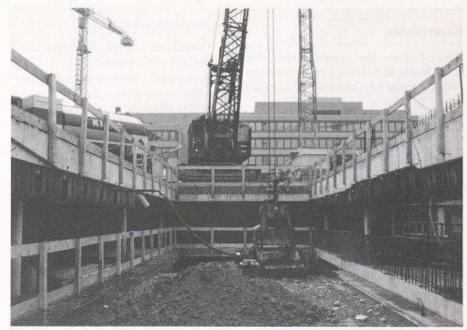
Bild 3. Aushub bei Deckelbauweise
