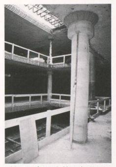
Bild 6. Der fertige Rohbau der Untergeschosse
