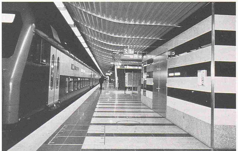
In Zürichs Hauptbahnhof präsentieren sich die neuen unterirdischen Perrons und Verbindungsgänge in schwarz-weissem Marmor. Die hierfür verwendeten Fassadenplatten bestehen aus einem sehr leichten Aerolam F-Board mit aufgeklebter dünner Natursteinplatte
