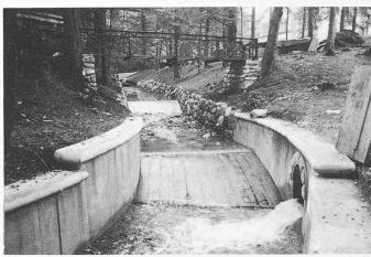
Bild 16. Die Unterhaltsstrecke am Wissenbach nach Ende der Sanierungsarbeiten 1987. Die Ufermauer rechts im Bild ist mit Spritzbeton aufprofiliert, die linke vollständig erneuert worden. Die Rampen aus Eichenholz sind in Anlehnung an frühere Bauverfahren rekonstruiert worden.
