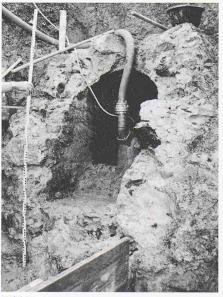
Bild 18. Angeschnittener Grundablassstollen des Unteren Weihers. Die massive Konstruktion aus dem Jahre 1851 wies keinerlei Schäden auf und erübrigte jede Sanierung.
