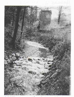
Bild 17. Neuer Uferschutz mit Blockrampe am Wissenbach. Die Konstruktion mit Blöcken entspricht den neuen Erkenntnissen des naturnahen Gewässerausbaues. Im Hintergrund der Turbinenturm der Seiltransmission.
