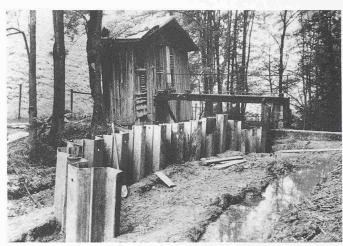
Bild 12. Das durch das Hochwasser 1977 teilweise zerstörte Obere Wehr mit der zum Schutze der Quellfassungen geschlagenen Spundwand 1977 (Bild der Wasserversorgung Wetzikon).
