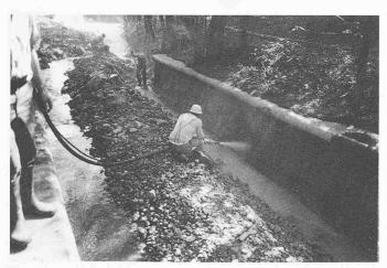
Bild 15. Aufprofilieren der teilweise zerstörten alten Ufermauern entlang der unterhaltspflichtigen Wissenbachstrecke. Die vorstehende Mauerkrone ist wiederhergestellt worden.
