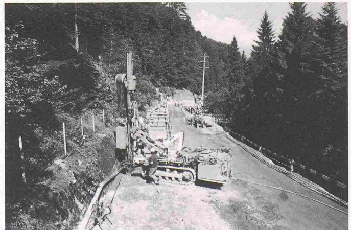
Bild 8. Jet-Grouting – Vorgang
