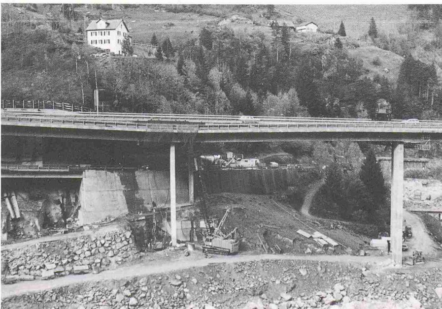
Bild 3. Stützmauersicherung mit Jet-Säulen (Situation)
