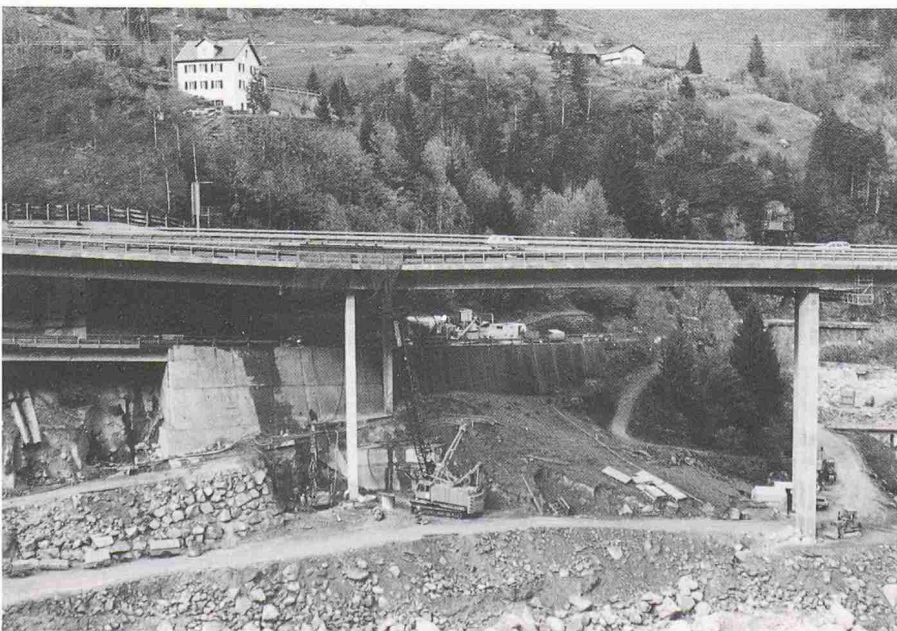
Bild 3. Stützmauersicherung mit Jet-Säulen (Situation)
