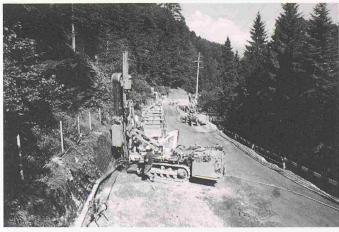
Bild 8. Jet-Grouting - Vorgang
