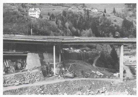
Bild 3. Stützmauersicherung mit Jet-Säulen (Situation)
