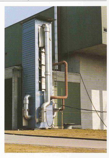
Bild 5. Ansicht der DeNO<sub>x</sub>-Pilotversuchsanlage an der KVA Müllheim zur Entstickung von Rohgas mit mehr als 120 mg Staub/Nm³
