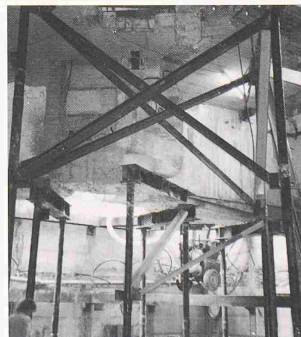
Bild 8. Ausgesteifte Pfähle. Im Hintergrund die vier Joche für Südwestfassade
