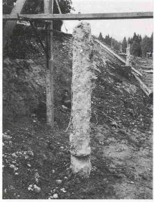
Bild 2. Mikropfahl  $\varnothing = 180$  mm, mit Stahlkern Swiss-Gewi  $\varnothing = 50$  mm
