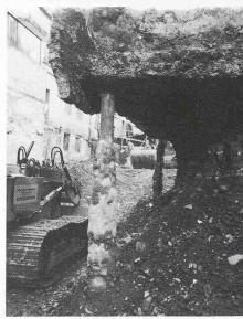
Bild 3. Mikropfahl  $\varnothing = 150$  mm, mit Stahlrohr  $\varnothing = 114$  mm
