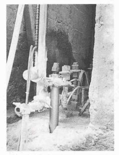
Bild 11. Bohrgerät für Gewi-Pfähle
