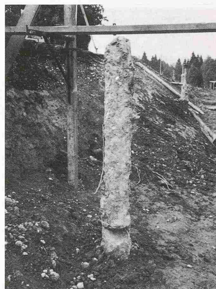
Bild 2. Mikropfahl \varnothing = 180 mm, mit Stahlkern Swiss-Gewi \varnothing = 50 mm
