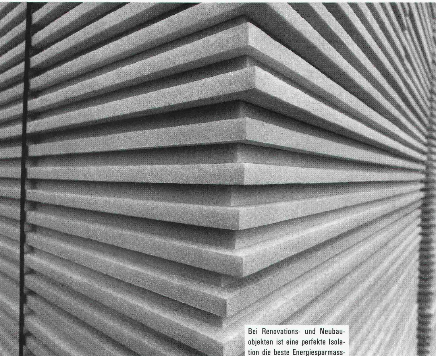
Bei Renovations- und Neubauobjekten ist eine perfekte Isolation die beste Energiesparmaßnahme. Extrudierte Polystyrol-Hartschaumplatten bieten optimale Eigenschaften und lassen sich vom Keller bis zum Dach, für die Innen- wie für die Außenisolation einsetzen.
