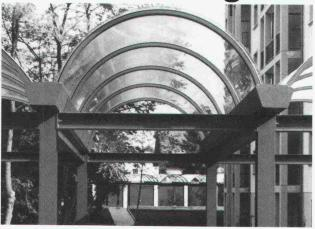
Glasklar oder Rauchfarben. Die leichte, elegante Lösung für Lichtbänder, Eingänge, Unterstände... inklusive Unterkonstruktion und Montage direkt ab Werk. Variante in schlagfestem Polycarbonat oder Polyester-Tonnengewölbe (Farbe nach Wahl).
