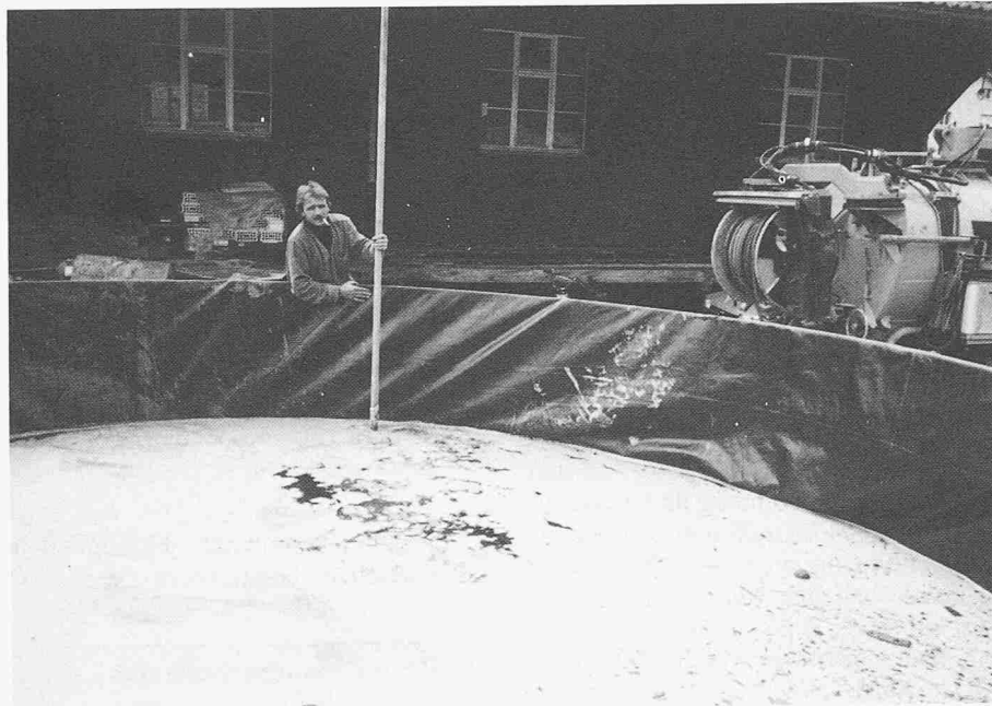
Bild 3. Mobiler Schnellmontage-Behälter im Katastrophen-Einsatz, Inhalt 45 000 Liter (Rückhaltung von durch Farben und Lösungsmittel kontaminiertem Überschwemmungsgut)
