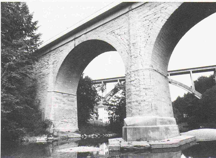
Die imposante Kräzernbrücke überspannt die Sitter in einer Höhe von 25 m in zwei Gewölbebogen. Sie ist aus behauenen Quadern aus verschiedenen Molassesandsteinarten der Gegend gemauert (Bild: Comet)
