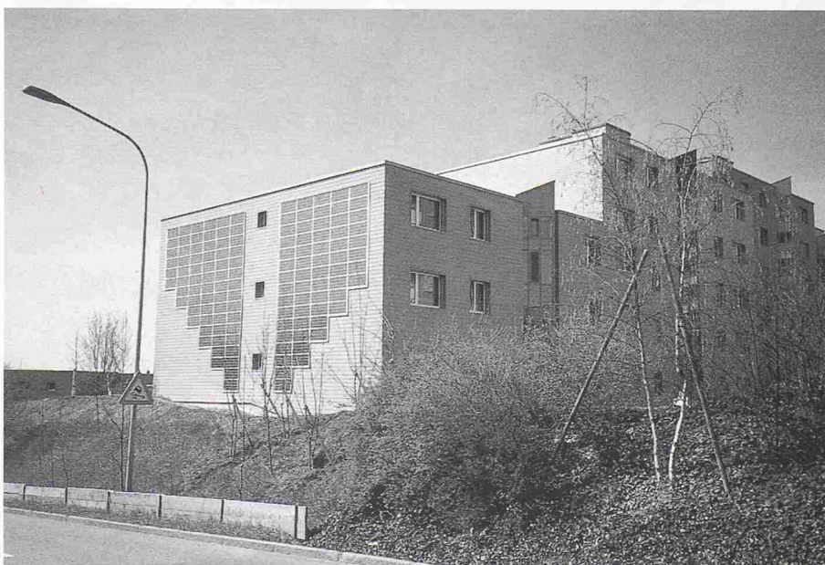
Bild 1. In Wohnhausfassade integrierte Photovoltaik-Zellen in Zürich-Höngg
