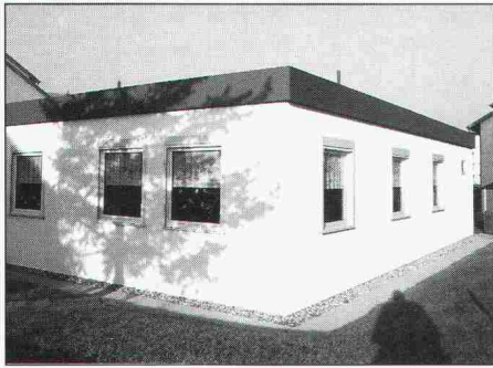
Kindergartengebäude der Schulgemeinde Wangen/Brüttisellen. Aussenverkleidung mit Fassaden/Kratzputz.
