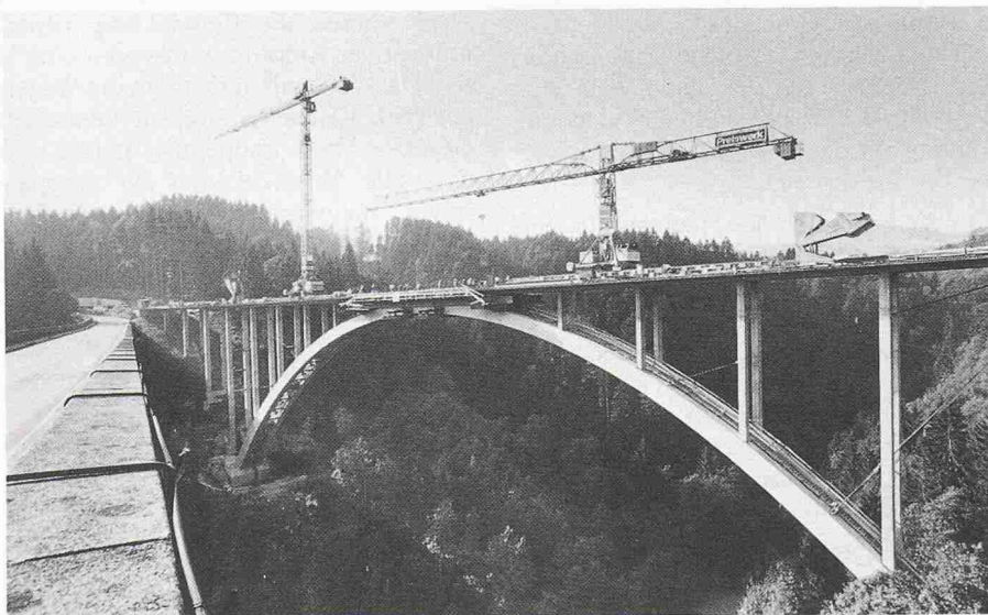
Die neue Hundwilertobelbrücke (Bild: H.U. Gantenbein)
