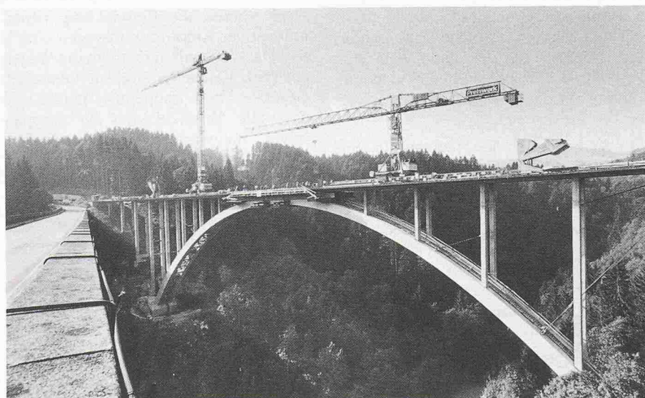
Die neue Hundwilertobelbrücke (Bild: H.U. Gantenbein)
