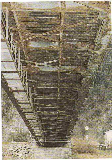
Bild 6. Verrostete Untersicht der Brücke
