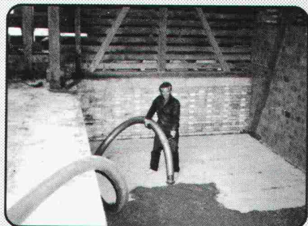
Absaugen von Zwischenböden bei Renovierungen, Umbauten und Sanierungen.
