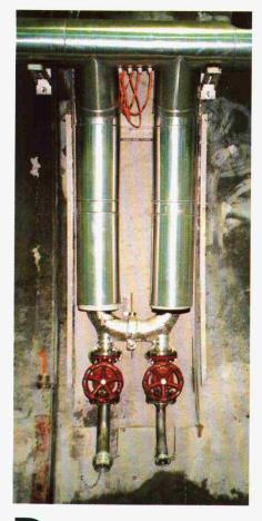
etailaufnahme eines Löschpostens im Rohbau. Deutlich erkennt man die bereits isolierten Zubringerleitungen sowie die beiden elektrostatisch innen und aussen epoxid-beschichteten Schieber (EKB), GGG-40, von SCHILLING.
