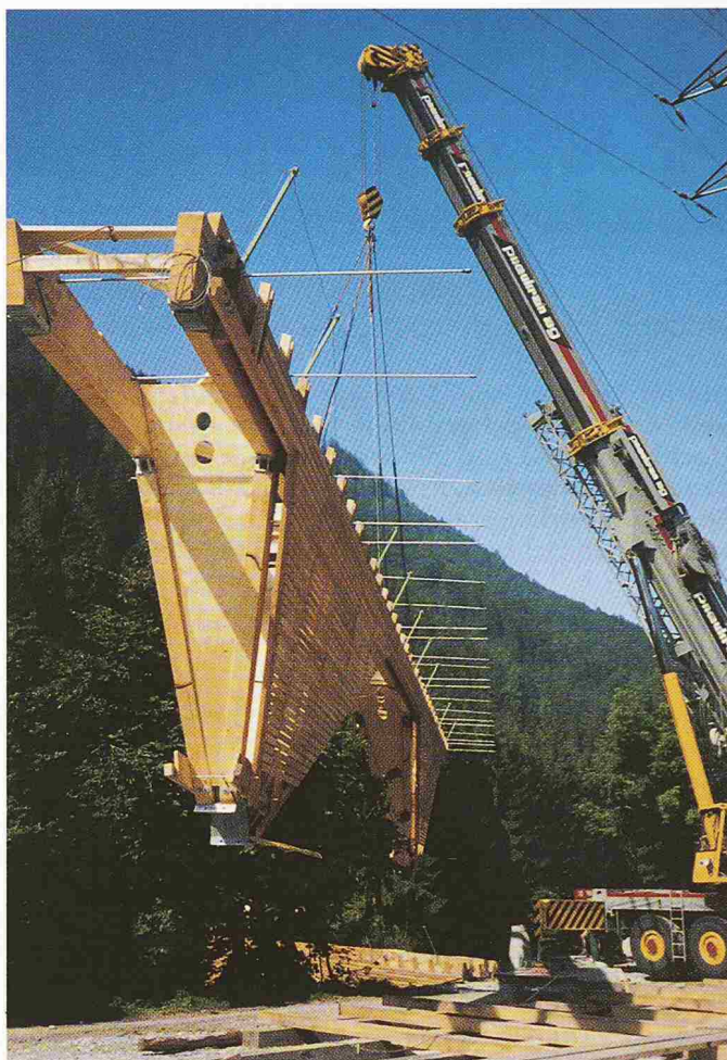
Eine Trägerhälfte wird angehoben
