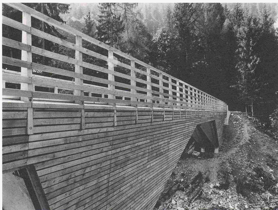
Ein Lärchenschild schützt das Tragwerk vor Witterungseinflüssen. Das Gelände ist einfach auszuwechseln
