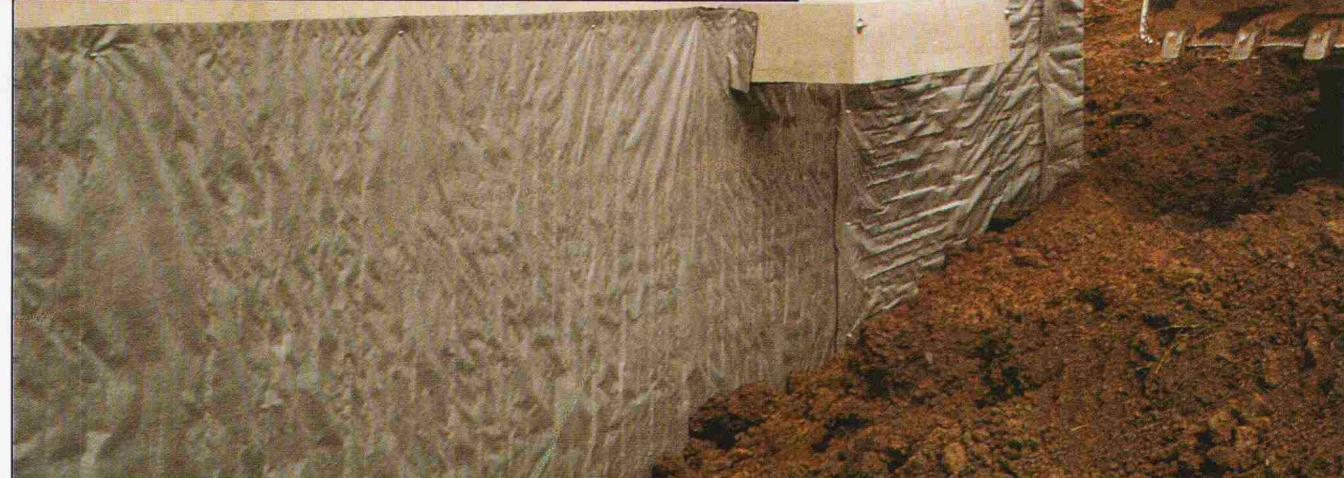
**Schicht 1:** Die zum Bauwerk gerichteten Noppen der Doppelnuppenbahn trennen sicher und dauerhaft Grundmauer und feuchtes Erdreich, sorgen für bessere Wärmedämmung und schützen die Abdichtung.
