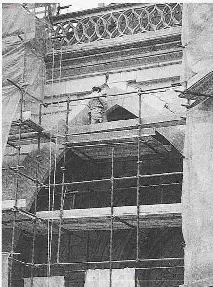
Restaurierungsarbeiten am Berner Münster (Foto: Institut für Denkmalpflege ETHZ)
