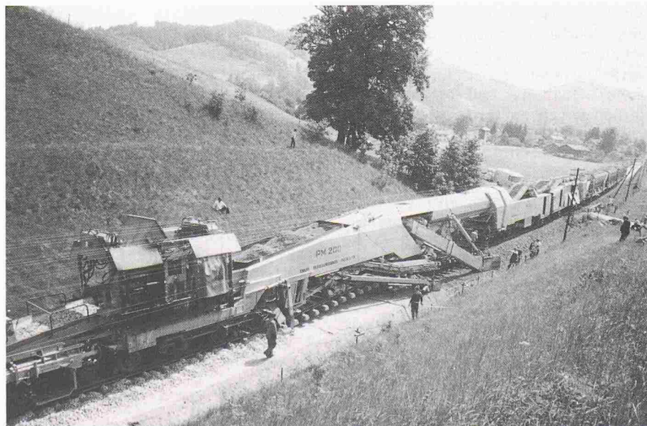
Bild 4. Planumsverbesserungsmaschine (PM 200)
