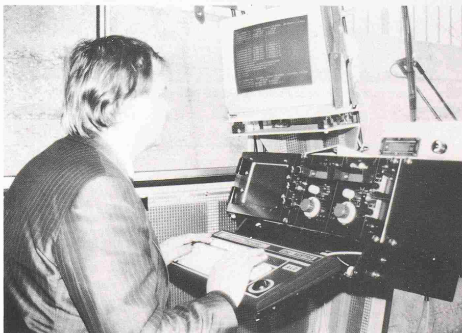
Bild 7. ALC-Zeitcomputer für Gleisstopfmaschinen
