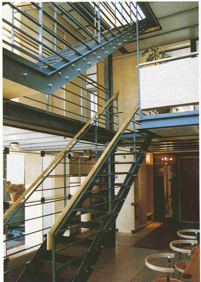
Industrietreppe aus Stahl; Wände, Böden und Schränke aus Sperrholz
