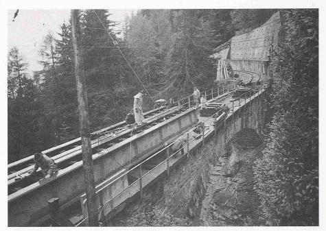
Bild 3. Einschub der Hilfsbrücke
