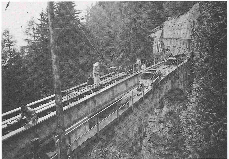
Bild 3. Einschub der Hilfsbrücke
