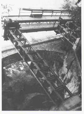
Bild 9. Stahlträger der neuen Brücke bis zur zweiten Hilfsstütze eingeschoben
