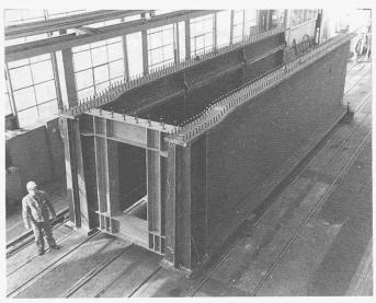
Bild 8. Werksmontage eines Auflagerschusses
