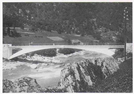
Rheinbrücke bei Tavanasa, 1905. Diese seitliche Ansicht zeigt die Öffnungen in den Seitenwänden. Der Block des Scheitelgelenkes liegt bündig mit der sonst auskragenden Fahrbahnplatte, und der Bogen weitet sich zu diesem Block hin auf
