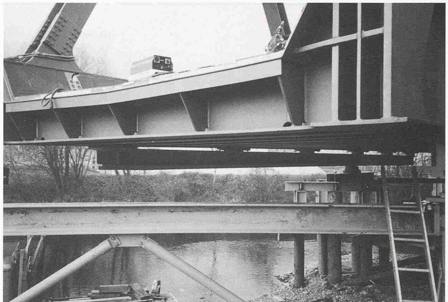
Bild 6. Endknoten am Auflager, Perspektive
