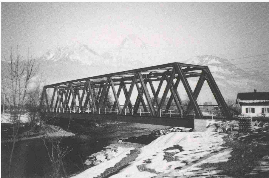
Bild 1. Neue Muotabrücke, Übersicht
