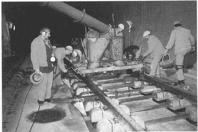
Bild 2. Einbetonieren eines schotterlosen Gleises
