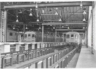
Bild 2. Neue Unterhaltsstände im bestehenden Depot F in Zürich (Foto D. Heer)
