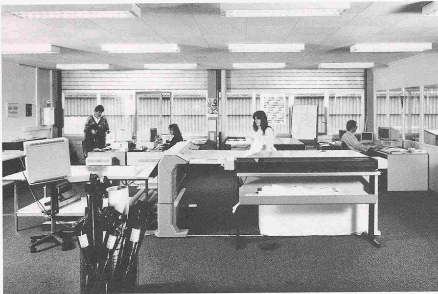
Bild 4. Dienstleistungszentrum für ein analog-digitales Plansystem: Scanner, Arbeitsplätze für die manuelle Nachbearbeitung und farbiger Elektrostatenplotter (Quelle: Multitec)
