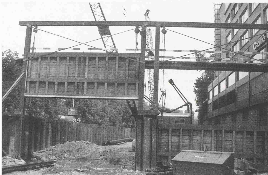
Bild 8. Fluttore unterhalb der Sihlbrücke. Linkes Tor während Bauarbeiten gezogen für die Durchfahrt des Baustellenverkehrs (Aufnahme SZU)
