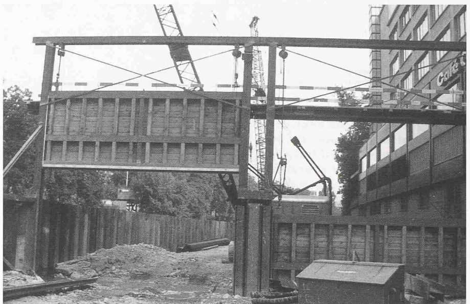
Bild 8. Fluttore unterhalb der Sihlbrücke. Linkes Tor während Bauarbeiten gezogen für die Durchfahrt des Baustellenverkehrs (Aufnahme SZU)
