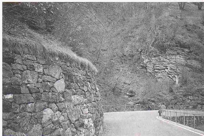
Bild 2. Enge Kurven und in sorgfältiger Handarbeit erstellte Trockenmauern prägen das Bild der historischen Passstrasse und machen den hohen Erlebniswert einer Passfahrt aus. Diese Elemente sollen bei der Sanierung weitgehend erhalten bleiben.
