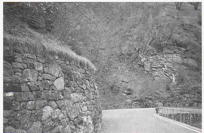
Bild 2. Enge Kurven und in sorgfältiger Handarbeit erstellte Trockenmauern prägen das Bild der historischen Passstrasse und machen den hohen Erlebniswert einer Passfahrt aus. Diese Elemente sollen bei der Sanierung weitgehend erhalten bleiben.
