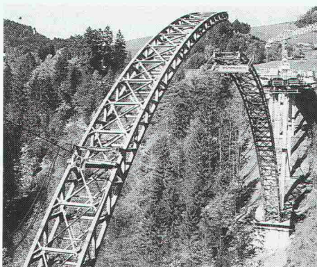
Hundwiler Tobelbrücke, 11. Oktober 1990, Einklappen der Fachwerkbogen
