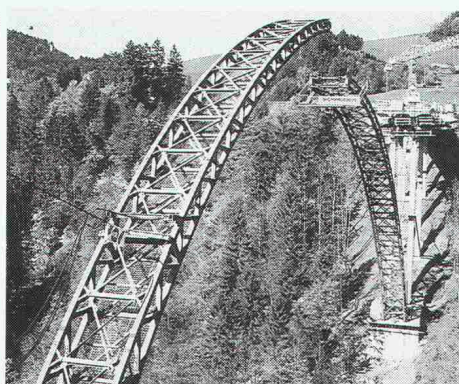
Hundwiler Tobelbrücke, 11. Oktober 1990, Einklappen der Fachwerkbogen
