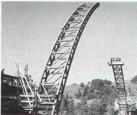
Hundwiler Tobelbrücke, 11. Oktober 1990, Einklappen der Fachwerkbogen
