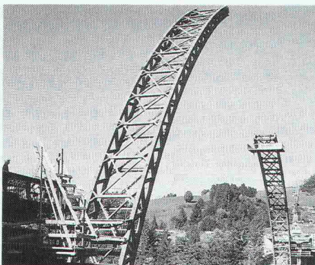
Hundwiler Tobelbrücke, 11. Oktober 1990, Einklappen der Fachwerkbogen
