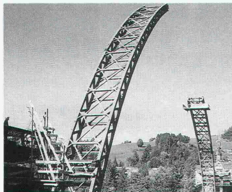
Hundwiler Tobelbrücke, 11. Oktober 1990, Einklappen der Fachwerkbogen
