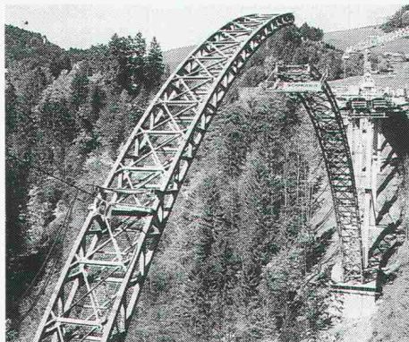
Hundwiler Tobelbrücke, 11. Oktober 1990, Einklappen der Fachwerkbogen
