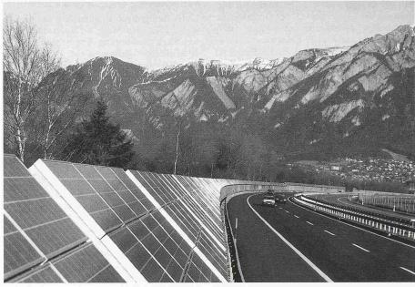
Bild 1. Das zurzeit grösste Photovoltaik-Panelfeld der Schweiz entlang der Autobahn N13 im Bündnerland
