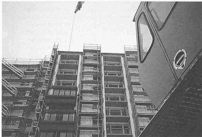
Bild 5. Versetzen der Balkonerker im November 1988
