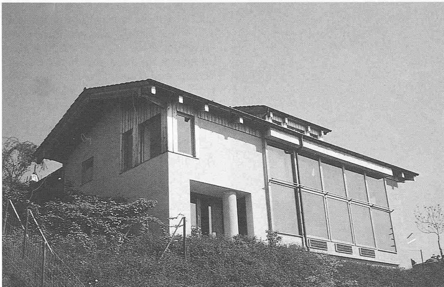
Bild 3. Südwestansicht mit dem Fensterkollektor
