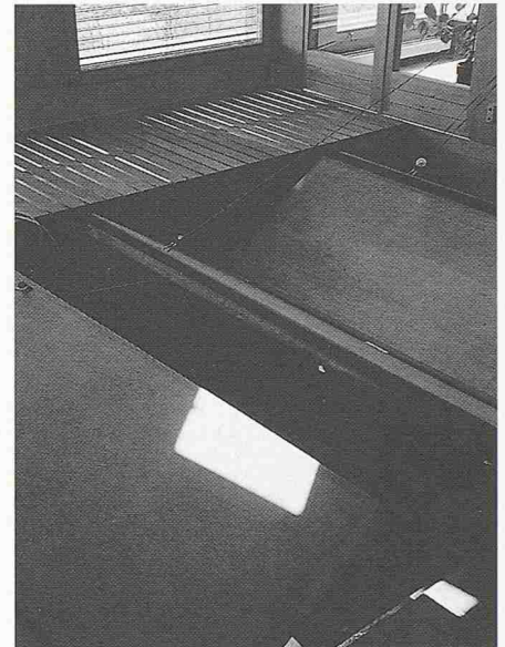
Bild 4. Im Wintergarten. Die begehbare Abdeckung über dem Schwimmbad ist halb geöffnet. Unter dem Rost befinden sich die Fischtanks
