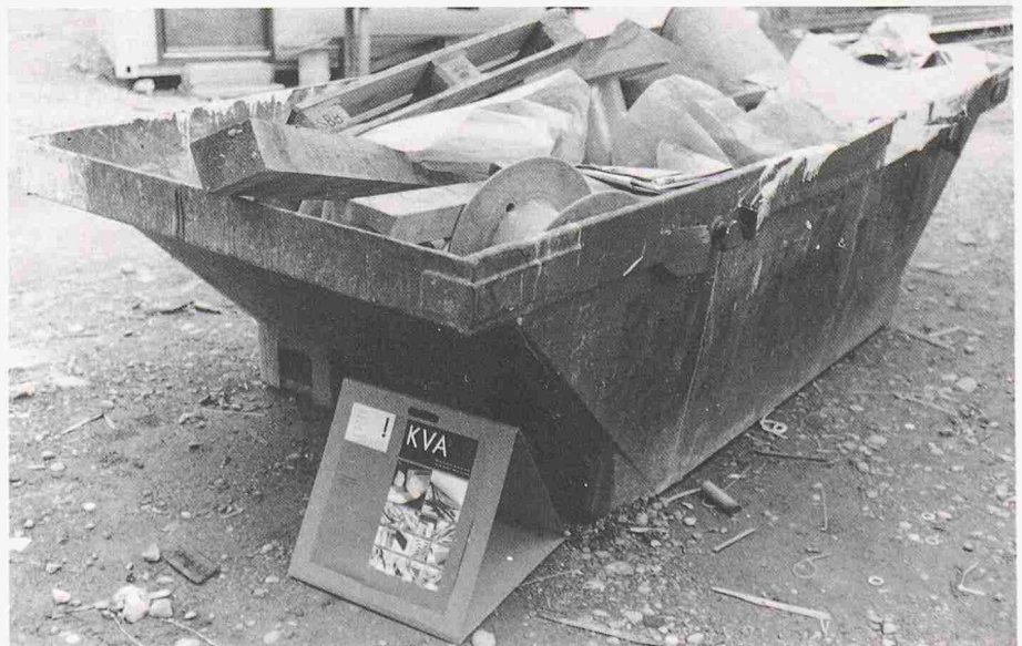
Bauschutt wird in gekennzeichneten Mulden konsequent getrennt gesammelt
