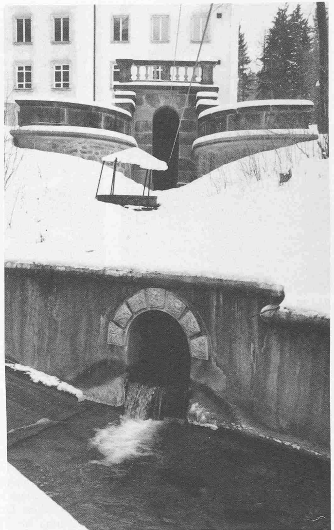
Bild 28. Kette von industriegeschichtlich wertvollen Zeugen des Industrie-Ensembles Neuthal: Wissenbach mit Kringelbacheindolung, gedeckter Einstieg zum Kontrollschacht des Turbinenauslaufstollens vom Fabrikgebäude, Transmissionsschlitz als integraler Bestandteil der früheren Parkanlage sowie im Hintergrund ein Teil des kürzlich durch den Kanton erworbenen Fabrikgebäudes
