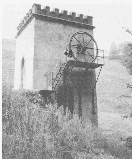
Bild 25. Turbinenturm der Seiltransmissionsanlage. An der Aussenwand des 1879/80 erbauten Turmes befindet sich das revidierte Transmissionsrad mit aufgespanntem Seil
