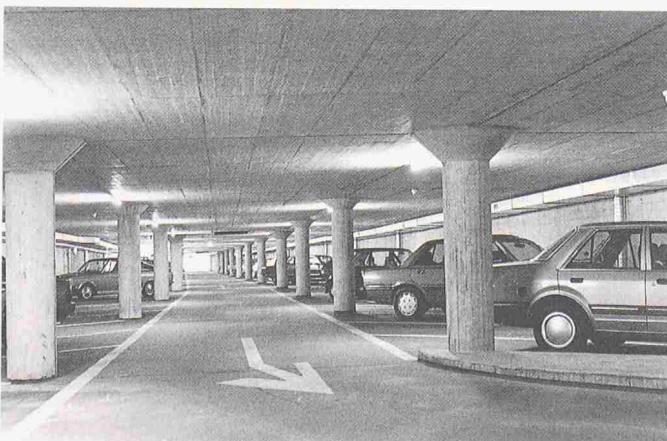
Bild 1. Innenansicht Parkhaus 1. Untergeschoss (September 1988)
