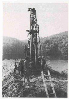
Bild 7. Modernstes Bohrgerät für die Ausführung der Jettingsäulen auf dem Erddamm Himmerichweiher. Während dem Rückzug der senkrecht in den Dammkörper gebohrten Bohrkrone wird mit hohem Druck ein Wasser-Zement-Gemisch in den Boden injiziert, welches zusammen mit dem Material des Dammes eine feste Säule bildet
