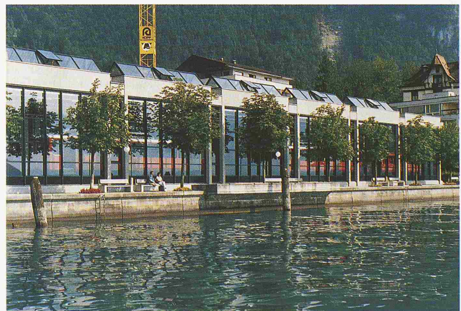
Seefassade, Gliederung und Proportionierung
