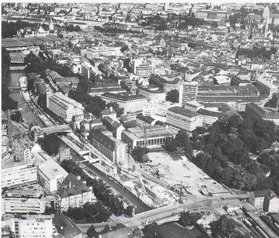
Bild 8. Baustelle der SZU-Verlängerung in offener Bauweise im September 1987, Photo Swissair, Photo und Vermessungen AG
