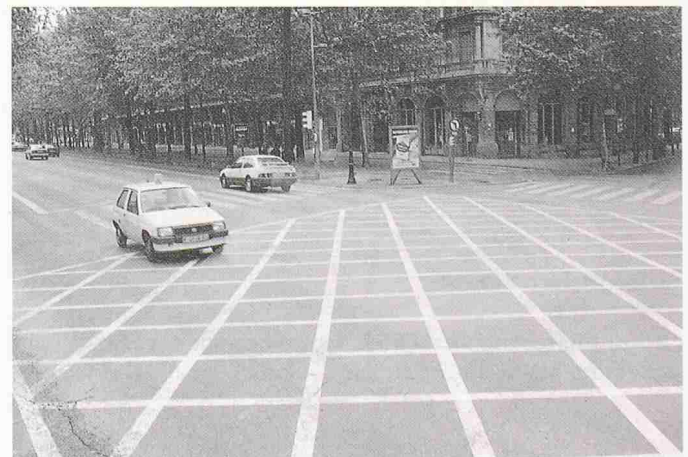
Bild 5. Sperrfläche im Kreuzungsbereich nach dem Modell der englischen «Box Junctions». In das gerasterte Feld darf nur eingefahren werden, wenn die Ausfahrt gewährleistet ist. Hiermit wird das Blockieren der Querrichtung vermieden.
