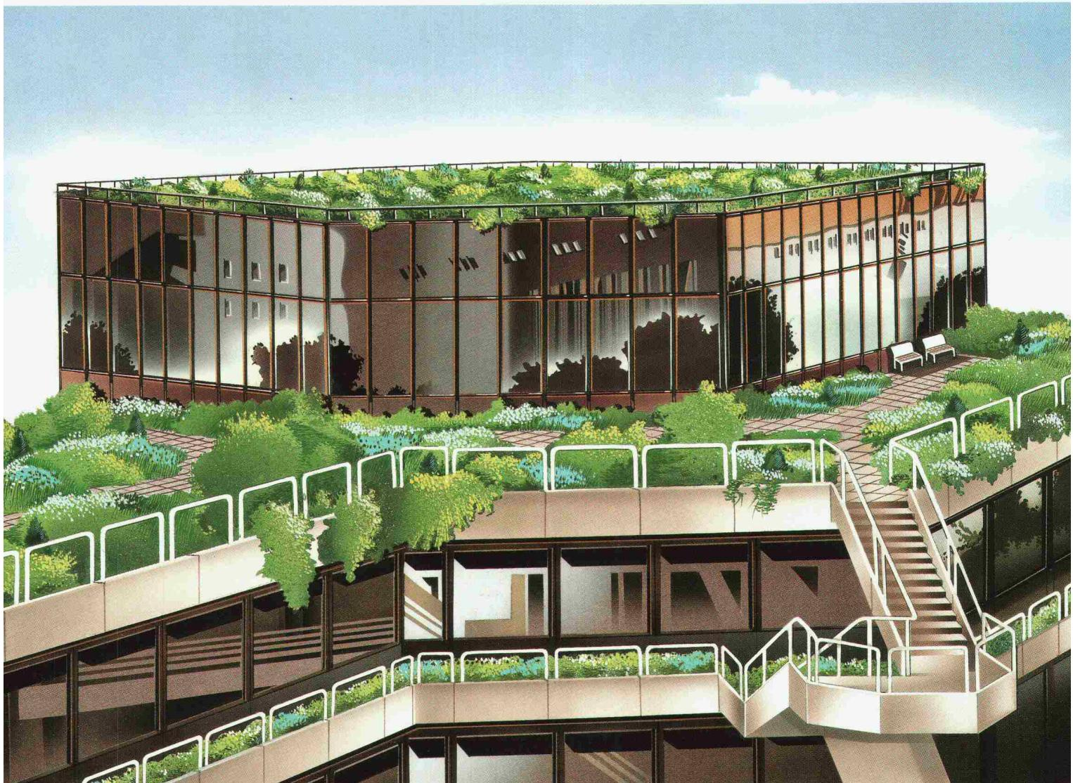
**Styrodur ist der ideale Wärmedämmstoff für begrünte und bepflanzte Flachdächer.** Das druckfeste Styrodur nimmt kein Wasser auf, ist alterungsbeständig und bietet deshalb einen dauerhaften Wärmeschutz. Diese besonderen Eigenschaften ermöglichen das Umkehrdachverfahren (UK-Dach). Styrodur wird über der Dachabdichtung verlegt. So wird sie vor mechanischen Einwirkungen
