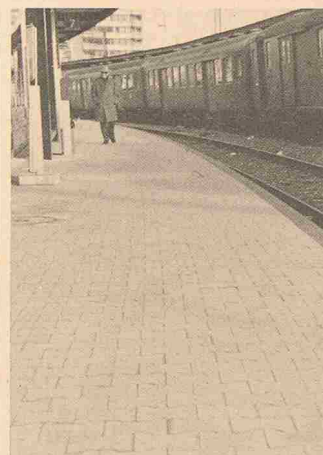
Einsatz von «Rolltyp»-Steinen beim neuen S-Bahn-Perron im Bahnhof Zug
