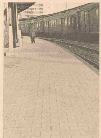
Einsatz von «Rolltyp»-Steinen beim neuen S-Bahn-Perron im Bahnhof Zug
