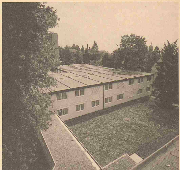
Das aus vorfabrizierten, mobilen Raumzellen zusammengefügte Klinikprovisorium während der Sanierung des Zürcher Bethanienospitals
