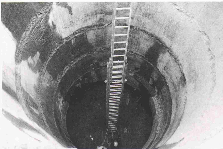
Bild 5. Blick in einen Kleinschacht während des Aushubes
