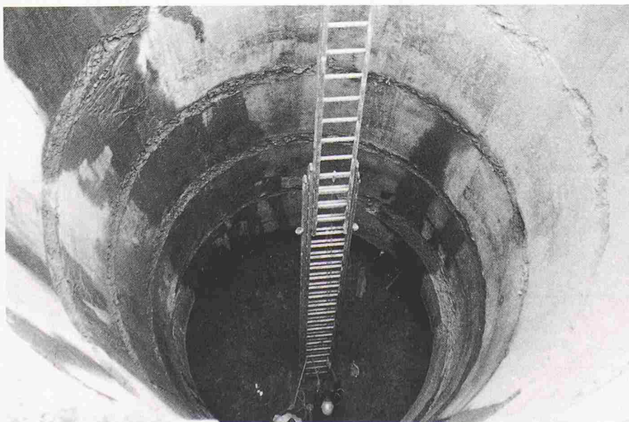
Bild 5. Blick in einen Kleinschacht während des Aushubes
