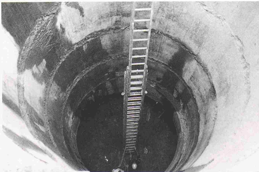
Bild 5. Blick in einen Kleinschacht während des Aushubes
