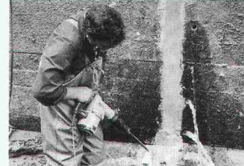
**Bei Umbauten/Sanierungen** gehören Injektions-Abdichtungen und -Verfestigungen praktisch immer zu den zentralen Massnahmen.
