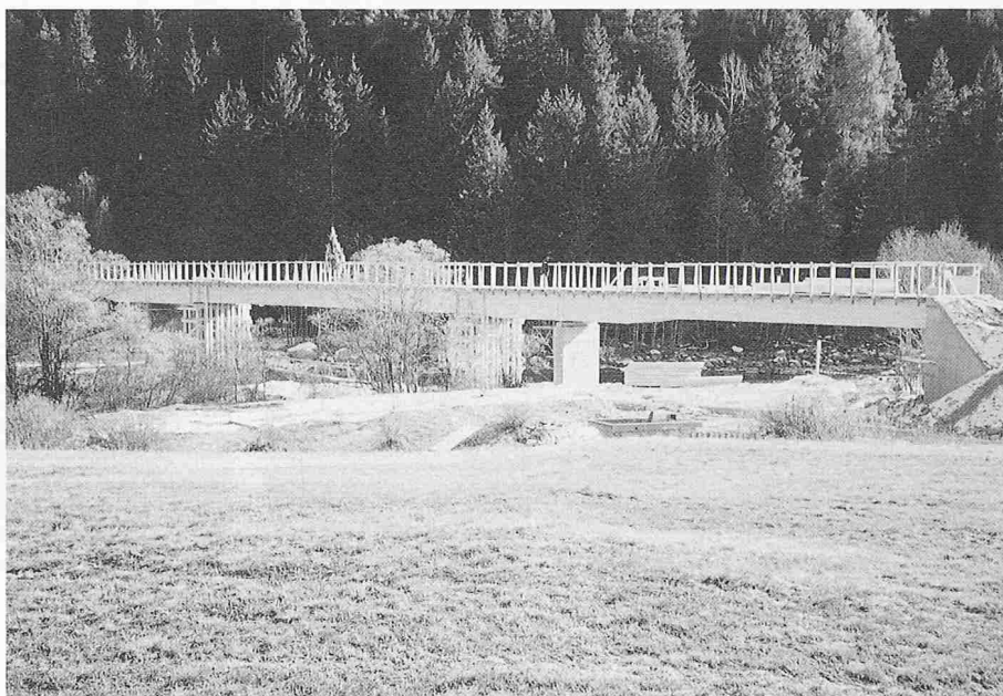
Bild 7. Von den Engadiner Kraftwerken erstellter Steg über den Inn im Unterengadin. Totale Länge 85 m; Breite 4,5 m. Kerto in Elementen von 22 m Länge dient als Fahrbahnplatte und als Aussteifung. Die Brücke wird vor allem von Ski-Longläufern und den Pistenfahrzeugen benutzt. Projekt: W. Bieler, Bonaduz.
