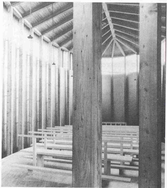
Die Feingliedrigkeit der Dach- und Deckenkonstruktion der Aula der Kantonsschule Wohlen zeigt, wie innovativ Holz eingesetzt werden kann
