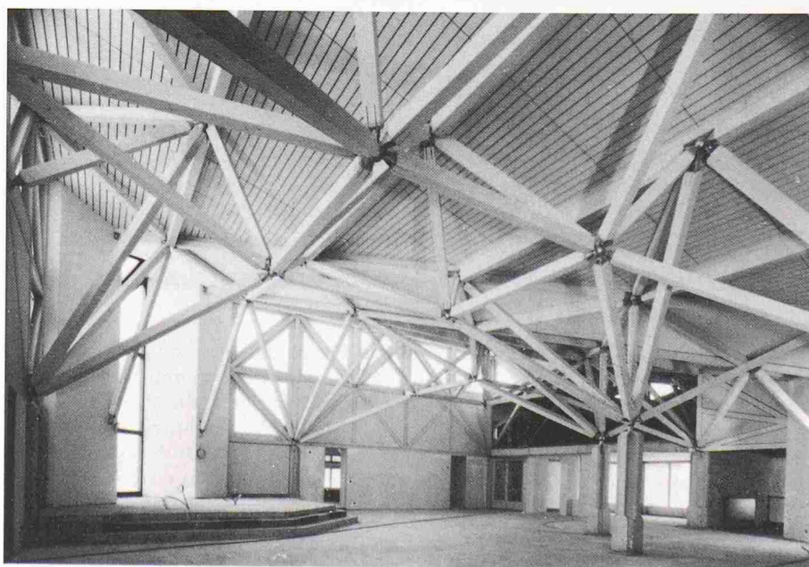
Die Kirche «St. Katharina von Siena» in Fällanden grenzt an ein Naturschutzgebiet. Im Innern steigern sich die Raumhöhen entsprechend der Bedeutung und werden im hohen Kirchenraum von einem sprengwerkartigen Raumfachwerk gleich einem Himmelsgewölbe überspannt
